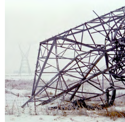
Pylône endommagé pendant la crise du verglas de 1998
