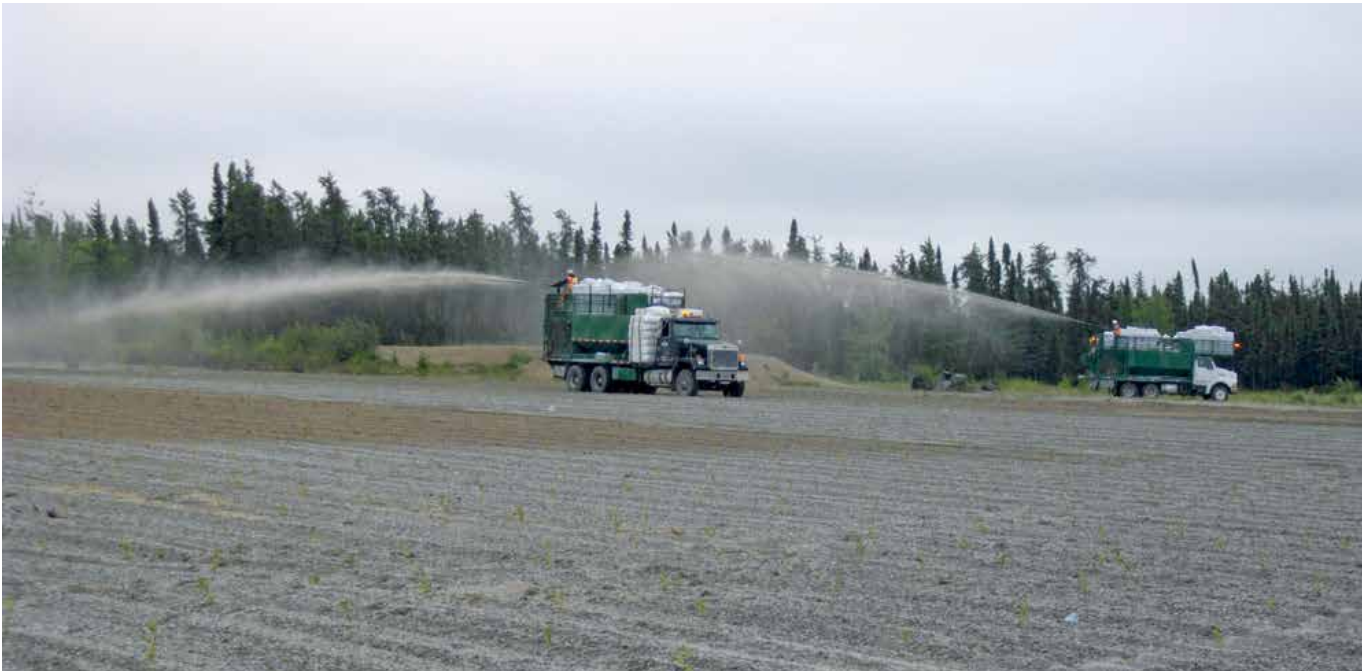
Travaux d'ensemencement hydraulique
