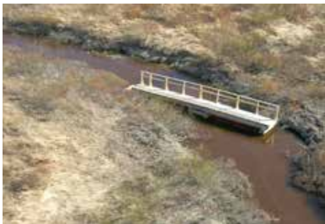
Passerelle en bois détachée de la rive par la marée
