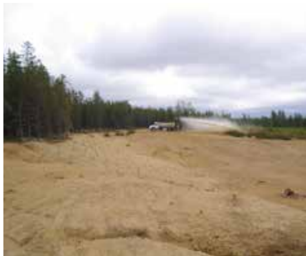
Ensemencement hydraulique d'une sablière près du campement de la Nemiscau
