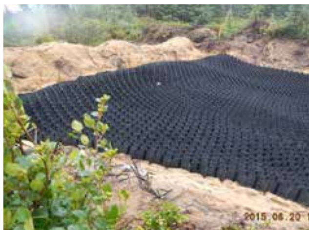
Mise en place de géogrilles de confinement
