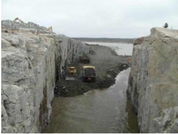
Travaux de fermeture de l'extrémité aval du canal de dérivation provisoire
