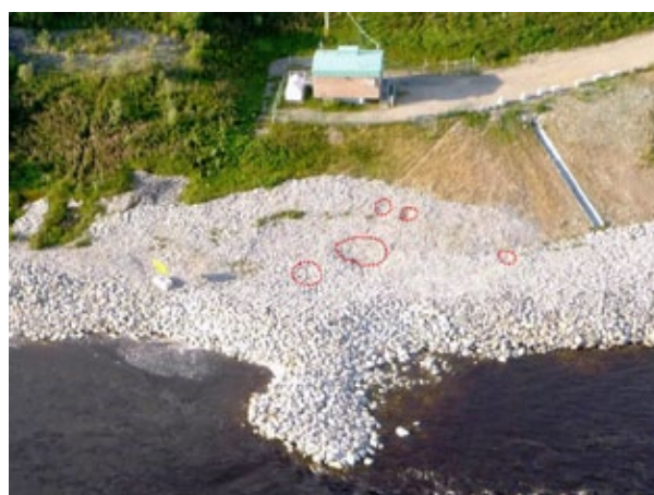
Petites dépressions observées à la surface de l'ouvrage de protection du talus à la prise d'eau de Waskaganish
