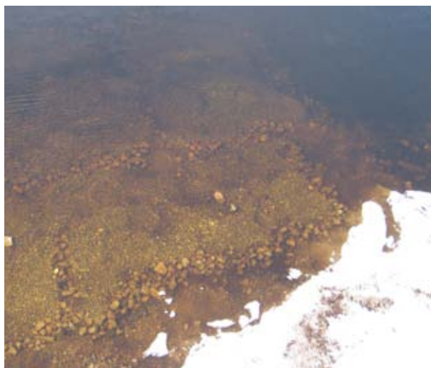
Frayère aménagée au PK 170 de la Rupert comportant deux plateaux inférieurs destinés au grand corégone (18 mars 2012)
