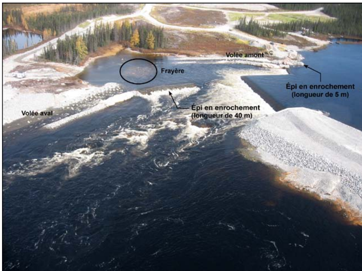
Seuil du PK 223 après la réalisation des travaux correcteurs (novembre 2011)
