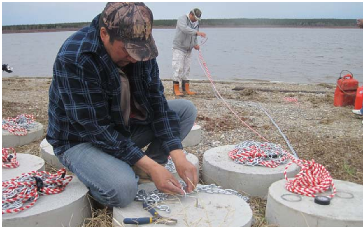
Préparation d'ancrages pour le balisage de chenaux de navigation dans la Rupert
