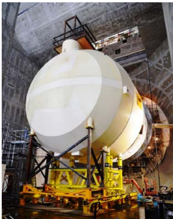
Alignement d'un groupe bulbe de la centrale de la Sarcelle
