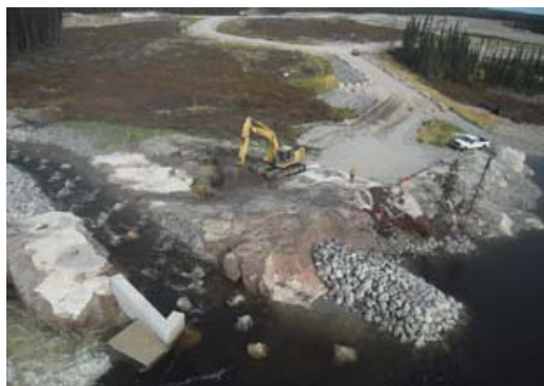
Épi de 5 m de longueur construit à l'entrée de la volée amont du chenal de montaison intégré au seuil du PK 223
