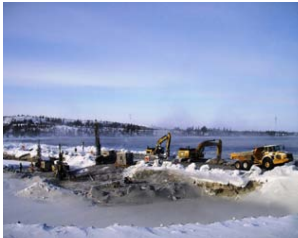
Travaux de dynamitage à l'emplacement du canal de fuite de la centrale de la Sarcelle
