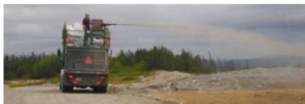
Ensemencement hydraulique d'une sablière
