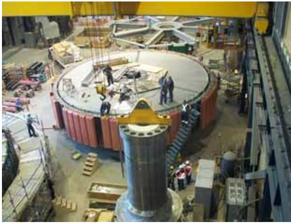
Installation de pôles de rotor à la centrale de l'Eastmain-1-A
