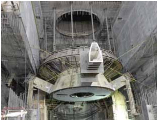
Montage d'un groupe bulbe à la centrale de la Sarcelle
