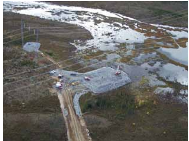
Construction d'un îlot pour supporter le pylône 418 en bordure du bief Rupert aval
