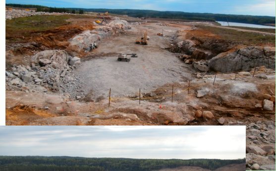
Excavation du canal d'amenée
