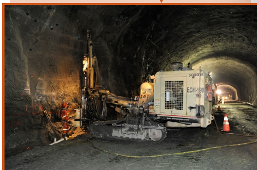
Percée frontale ↑ ↓ En banquette
