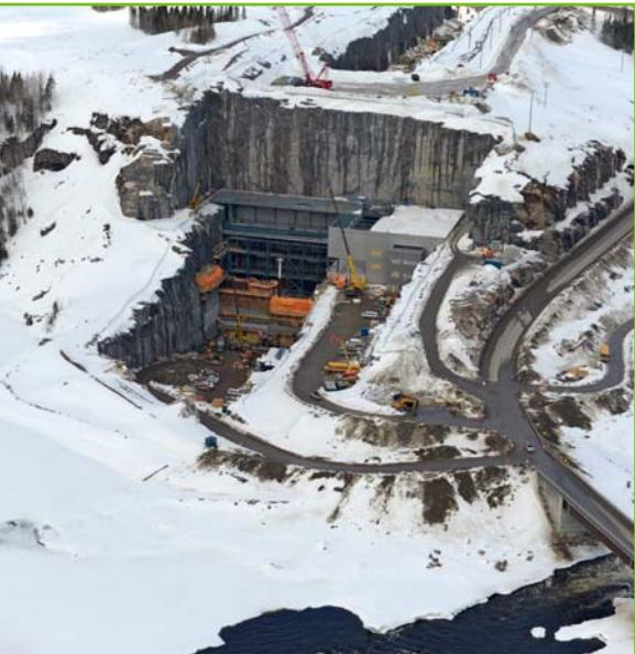
**SUR LE CHANTIER DE LA ROMAINE-1,** le bétonnage du mur aval de la centrale a repris durant l'hiver. On pourra ensuite monter la superstructure, puis installer le pont roulant. À la fin de l'été, on passera à la phase II du bétonnage, une fois que le turbinier aura installé les cônes d'aspirateur.
