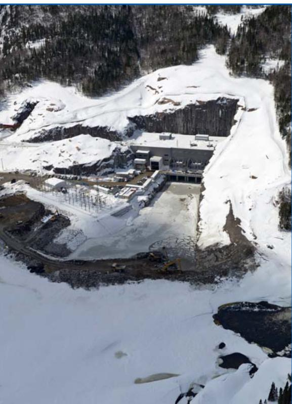
**SUR LE CHANTIER DE LA ROMAINE-2,** l'excavation du batardeau du canal de fuite de la centrale et du canal du bassin des Murailles sera achevée dans le courant de l'été. Suivra ensuite le bétonnage du bouchon de la dérivation, qui doit se terminer à la fin de l'année.
