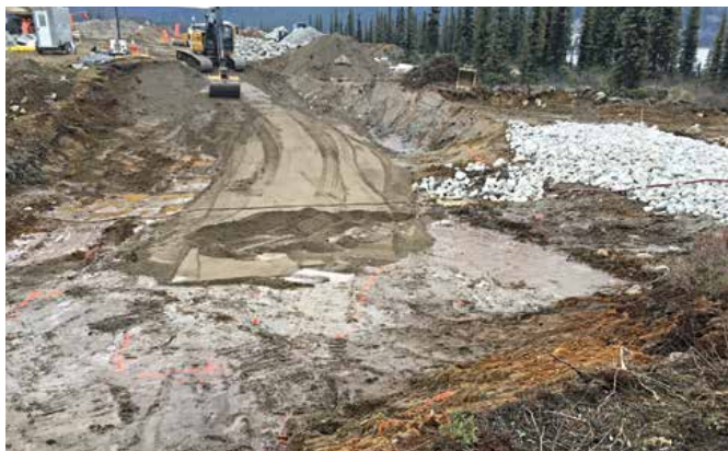
Aménagement d'un seuil infranchissable par les poissons dans le tributaire situé au PK 192 de la Romaine
