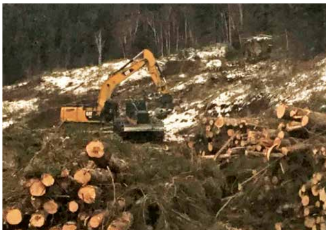
Ramassage des débris ligneux dans l'aire d'ennoisement du réservoir de la Romaine 4 à l'aide d'une pelle hydraulique
