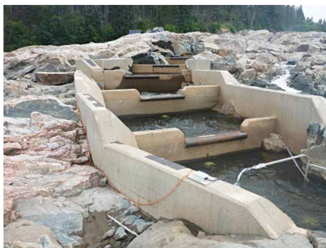
Passe migratoire à saumon sur la rivière Mingan munie d'antennes télémétriques en amont et en aval
