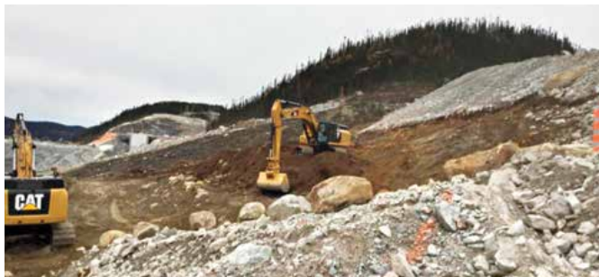
Décapage de l'emplacement de la rampe de mise à l'eau en rive du réservoir de la Romaine 4
