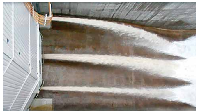
Vannettes d'une des vannes de l'évacuateur de crues de la Romaine-2 assurant le débit réservé en aval
