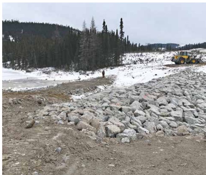
Seuil en enrochement et batardeau amont (en cours d'arasement) mis en place pour la protection de l'omble de fontaine présent dans le tributaire R1929248G
