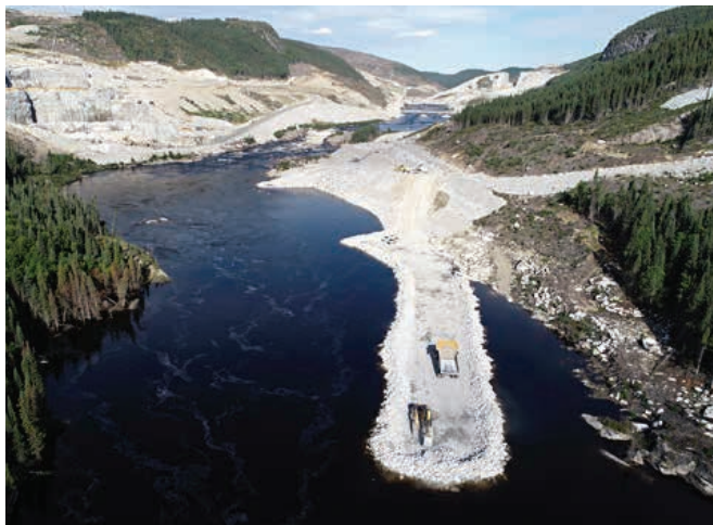
Jetée pour la construction du canal de fuite de la centrale de la Romaine-4
