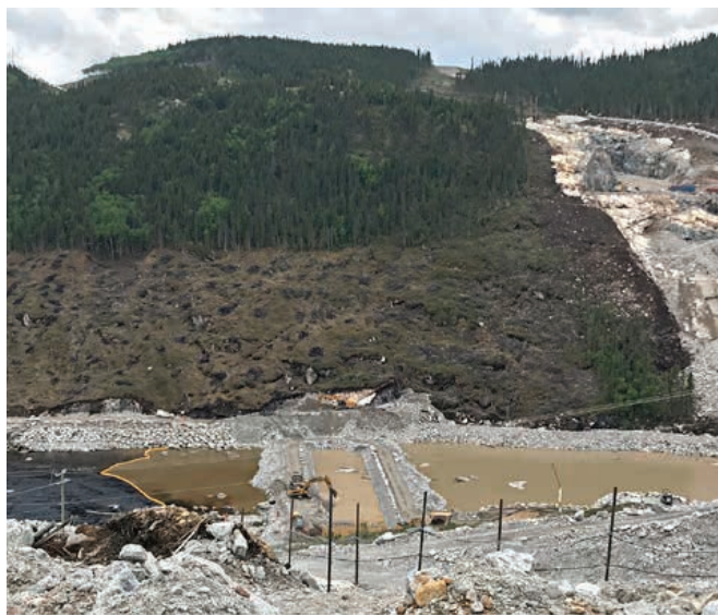
Construction du batardeau à l'aval du barrage de la Romaine-4 et rideau de confinement des sédiments
