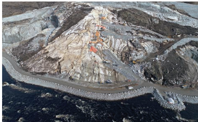
Décapage du mort-terrain jusqu'au roc à l'emplacement du barrage de la Romaine-4
