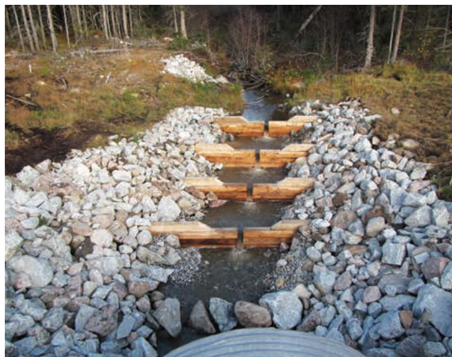
Seuils en bois mis en place en amont du ponceau du kilomètre 147+012
