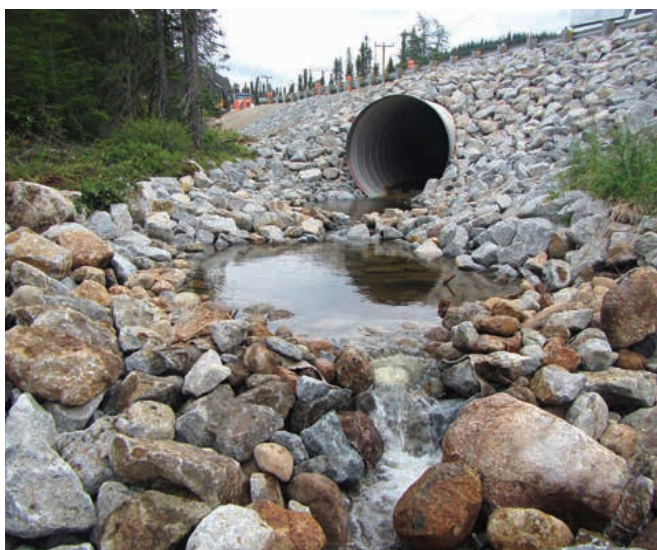
Seuils en enrochement aménagés en aval du ponceau du kilomètre 134+983
