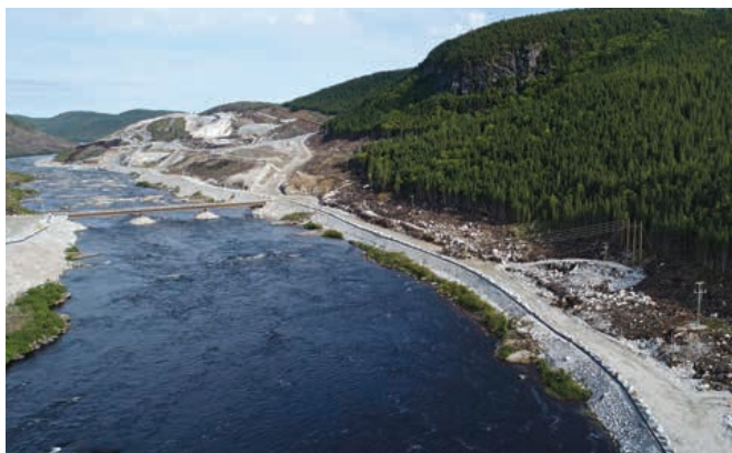
Pont provisoire sur la Romaine et chemin d'accès au barrage de la Romaine-4
