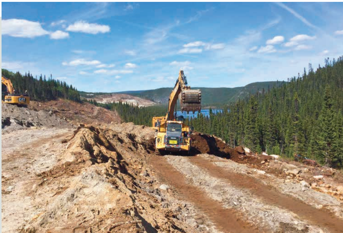
Chargement et transport des produits de décapage de l'emprise de la route
