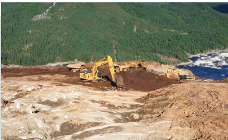
Décapage et excavation du mort-terrain au site de la centrale de la Romaine-4
