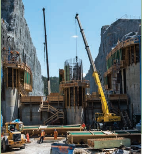
Coffrage et bétonnage de l'évacuateur de crues
