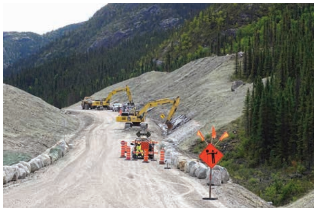
Stabilisation de talus entre les kilomètres 135 et 140 de la route de la Romaine
