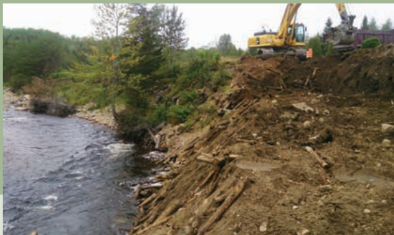
Démantèlement d'anciennes structures utilisées pour le flottage du bois
