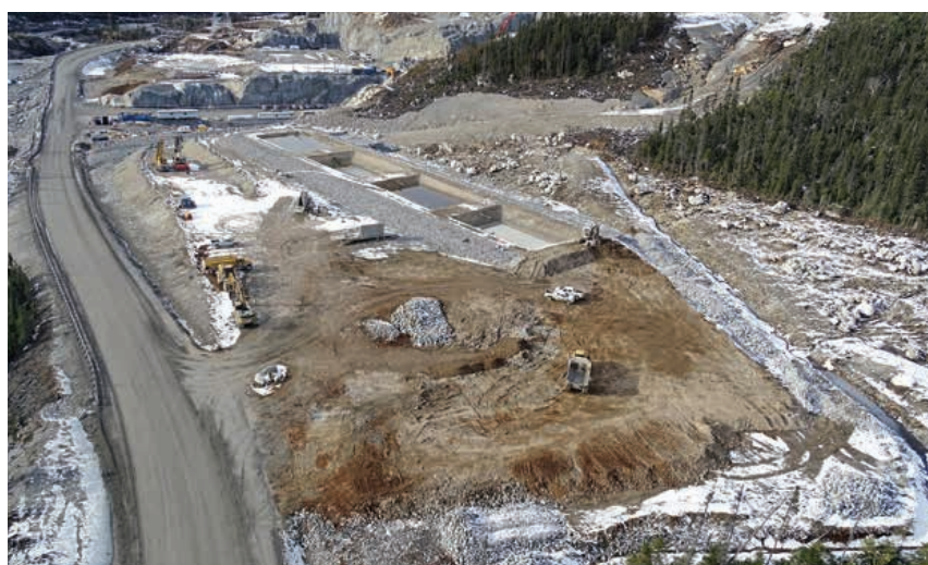
Bassins de filtration aménagés en amont des ouvrages de la Romaine-1
