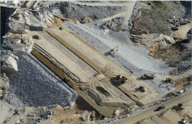
Travaux de remblai à la digue B3
