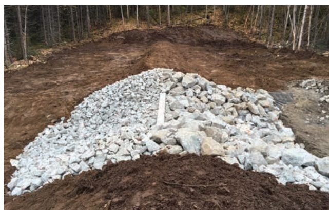
Seuil déversant construit sur un ancien lit de cours d'eau à l'étang aux Bouleaux
