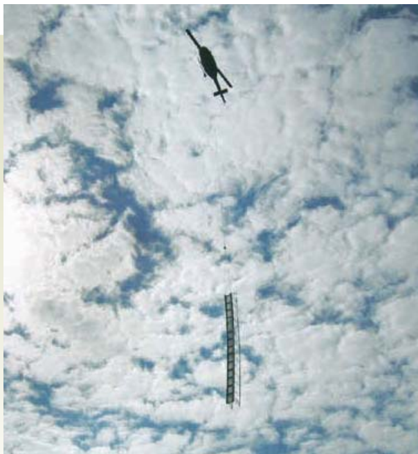
Installation d'une passerelle sur la rivière Moisie
