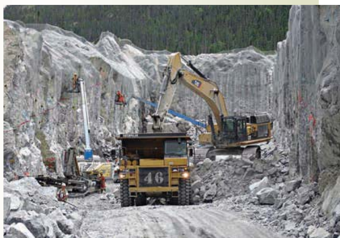
Travaux au canal de fuite de la centrale de la Romaine-3
