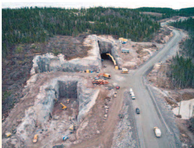
Construction de la galerie d'amenée et de la galerie de dérivation
