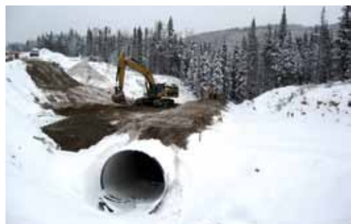
Ponceau installé sur la route de la Romaine
