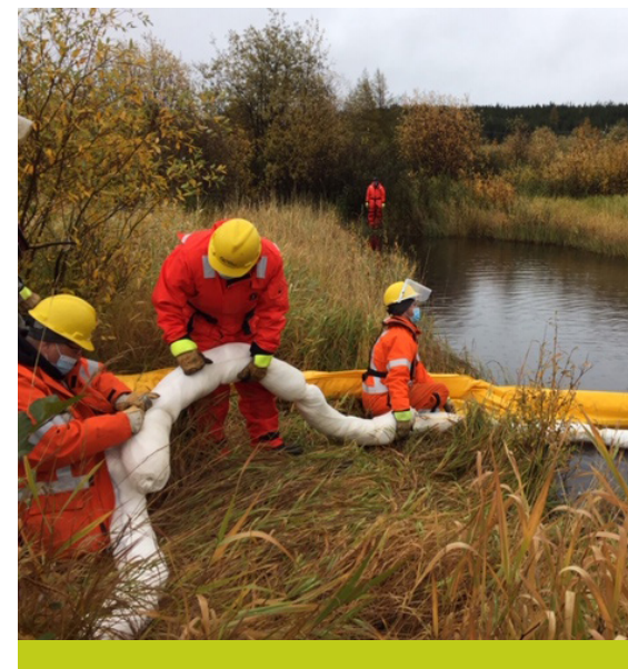
Employés déployant une estacade et des boudins dans le cadre d'une simulation à proximité de la centrale Robert-Bourassa
