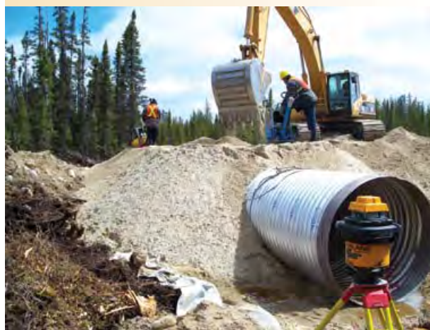
Mise en place d'un ponceau permanent au PK 4 de la route du bief Rupert aval
