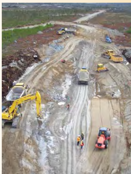
Mise en place de remblai à l'emplacement de la digue LR-12A
