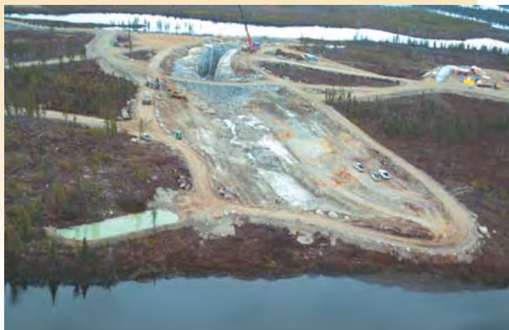
Bassin de décantation et excavation à l'amont du canal de restitution de la Nemiscau-1
