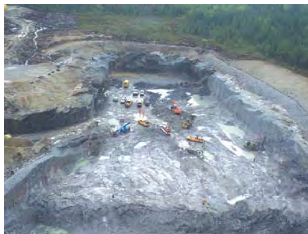
Excavation du portail amont du tunnel de transfert
