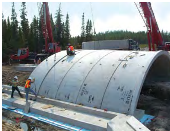
Mise en place d'un ponceau semi-circulaire sur la route du bief Rupert aval près du barrage de la Nemiscau-2
