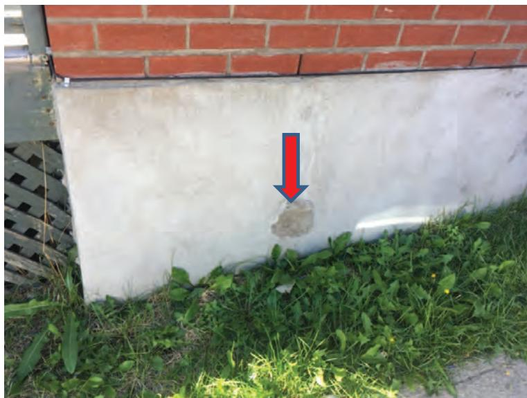
**Photographie 6 :** Vue d'un trou bouché dans la fondation (montré par la flèche rouge) sur le bâtiment sis au 388-398, 2<sup>e</sup> Rue. Celui-ci serait probablement associé à la présence antérieure d'un tuyau de remplissage d'un réservoir de mazout.
