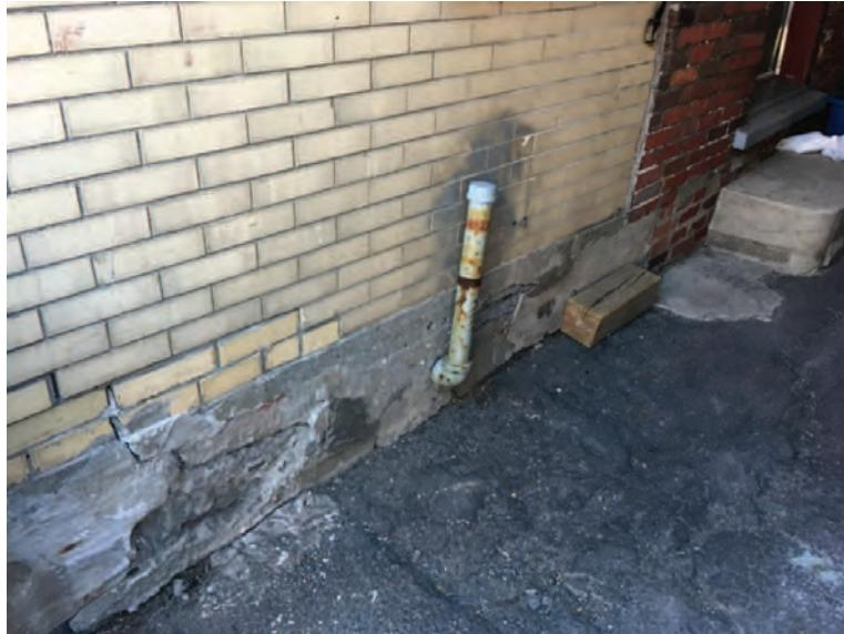
**Photographie 5 :** Vue du tuyau de remplissage, probablement relié à un réservoir de mazout, observé sur le bâtiment sis au 393 ½-399A, 2<sup>e</sup> Rue.
