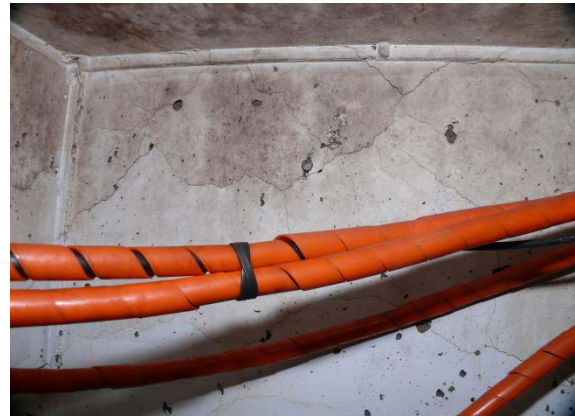
Gaine spiralée autour des câbles de télécommunications.
