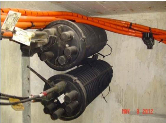
Boîtiers de jonction superposés (à proscrire).
