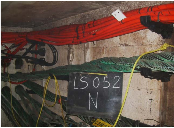
Installation d'une boucle de maintenance.
