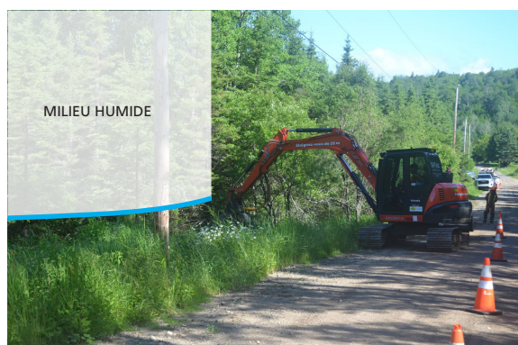
Machinerie qui travaille à partir de la voie carrossable pour éviter de circuler dans le milieu humide qui a préalablement été délimité par le fournisseur avec un ruban.
