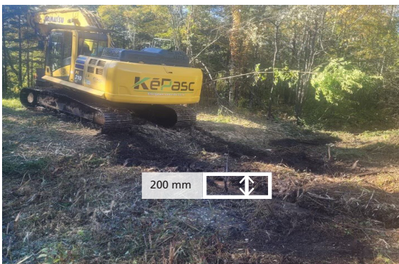
Ornières de plus de 200 mm de profondeur créées par le passage de la machinerie dans un sol de faible capacité portante.
