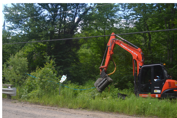
Déboisement sélectif réalisé avec la machinerie.
