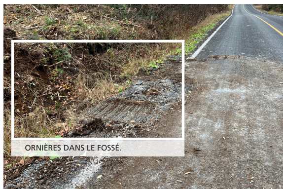
Fossé endommagé par le passage de la machinerie.
