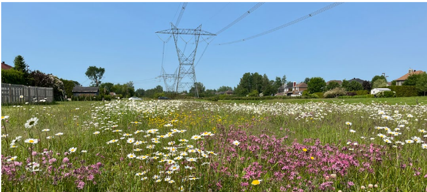
Un bel exemple de gestion différenciée de la végétation dans une de nos emprises de lignes de transport.
