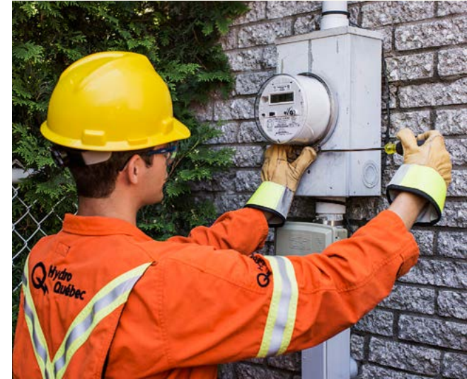
Jean-Simon Désilets installs a next-generation meter.
