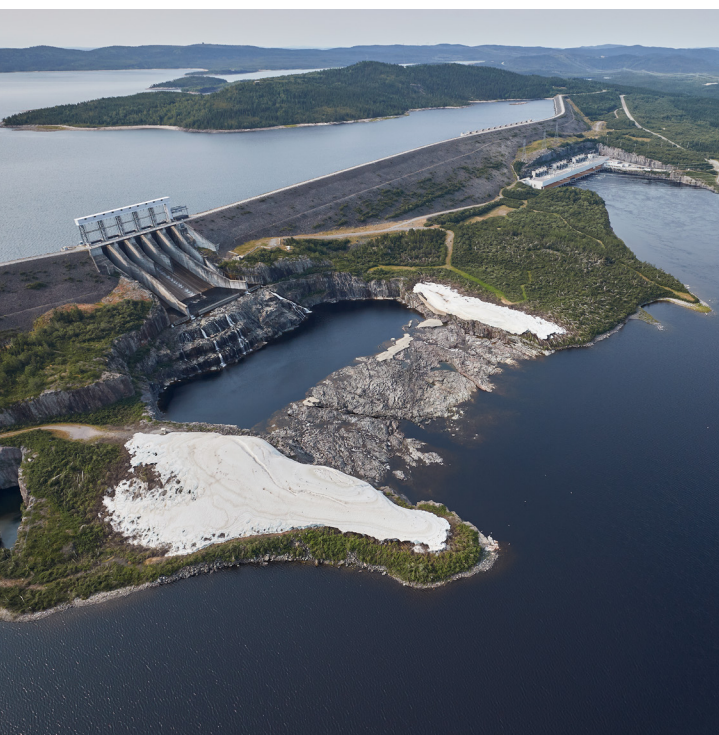
Évacuateur de crues, barrage, centrale et poste de départ, centrale La Grande-3
