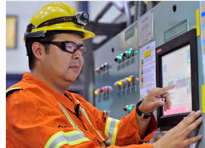
L'électricien d'appareillage Jasmin Mowatt devant le panneau de contrôle du système oléopneumatique d'un groupe de la centrale de la Sarcelle.
