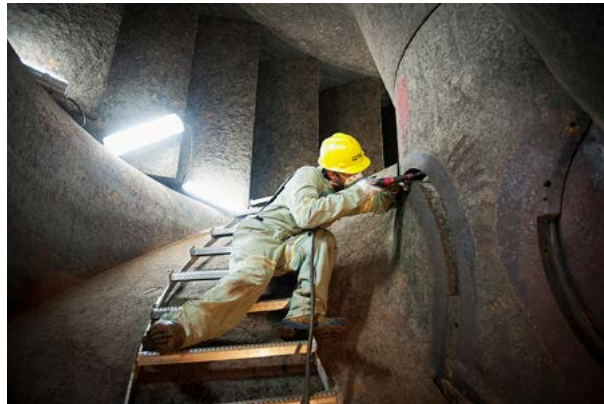
Le mécanicien d'appareillage Carl Lalande exécute des travaux de maintenance sur un groupe turbine-alternateur de la centrale de Carillon, dans les Laurentides.
