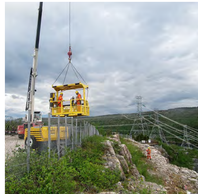
Une nacelle pour grue avec appareil de forage conçue par des employés de la direction – Production du Saguenay–Lac-Saint-Jean, sera finaliste au Gala national des Grands Prix santé et sécurité du travail de la Commission des normes, de l'équité, de la santé et de la sécurité du travail.
