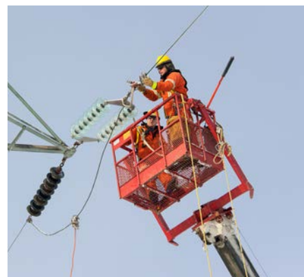
Le chef monteur Réjean Morin et le monteur Guy jr Lavoie remplacent des isolateurs sur une ligne de transport à 120 kV.
