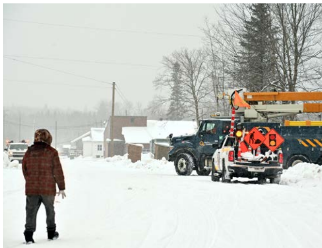
Après trois années de travaux, le village de Kitcisakik a été raccordé au réseau d'Hydro-Québec.
