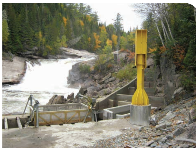
Cage de rétention sur la rivière Sainte-Marguerite (Photo : AECOM)
