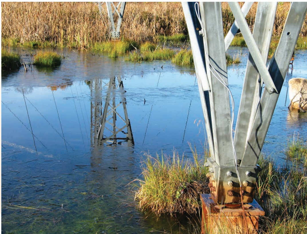
La variation du niveau d'eau provoque une corrosion prématurée de l'acier à la base des pylônes
