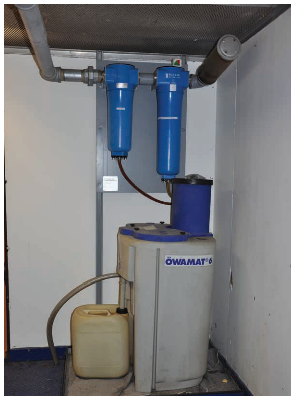
Séparateur eau-huile des effluents des compresseurs reliés aux disjoncteurs à air
