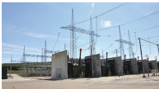
Transformateurs de puissance protégés par un système de récupération d'huile
