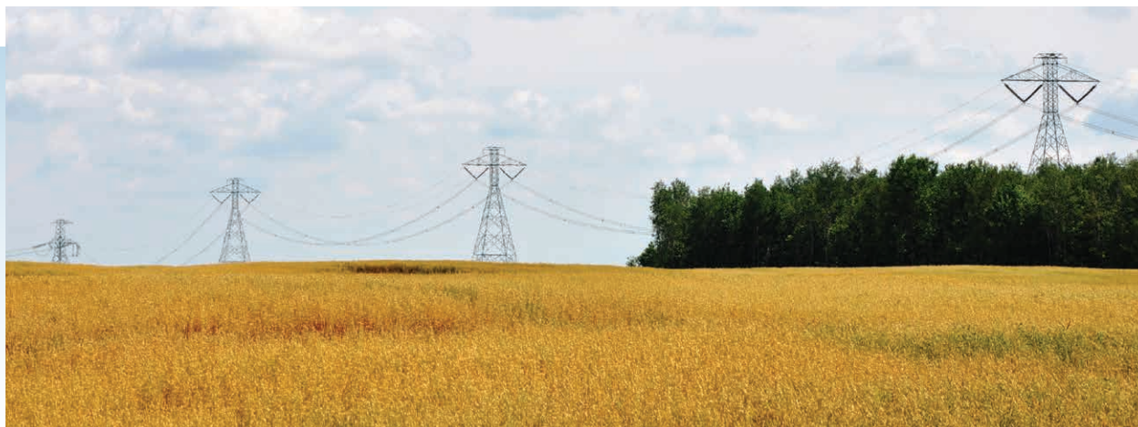
Ligne de transport à 450 kV c.c. sur pylône en acier galvanisé en milieu agricole
