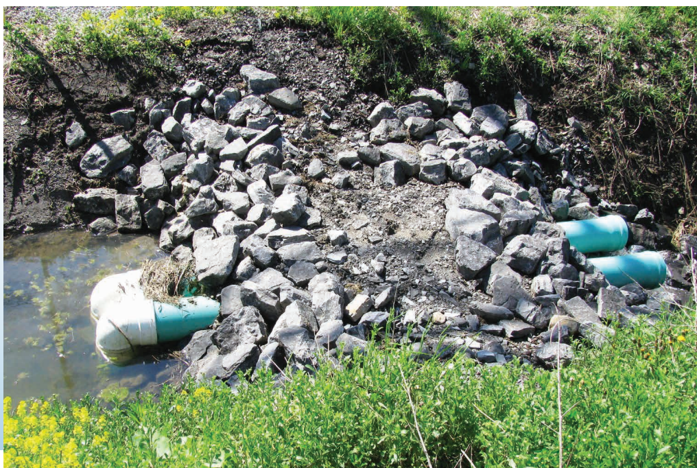
Digue installée dans un fossé afin de limiter la propagation d'un déversement
