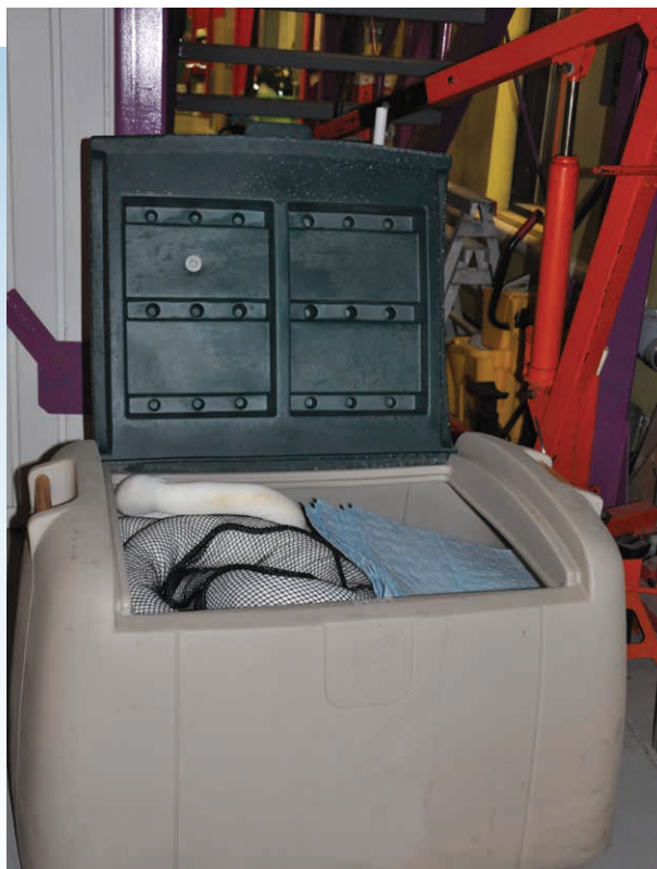
Coffre renfermant du matériel d'intervention en cas de déversement accidentel dans un poste
