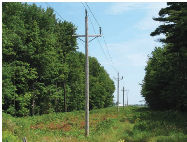
Ligne de transport à 49 kV sur poteau traité au pentachlorophénol
