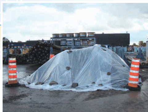
Entreposage en pile de sols contaminés dans une cour d'un CAS
