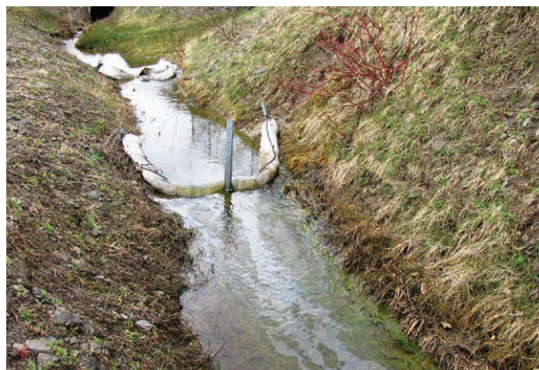
Matériel d'intervention installé dans un fossé pour limiter la propagation d'un déversement
