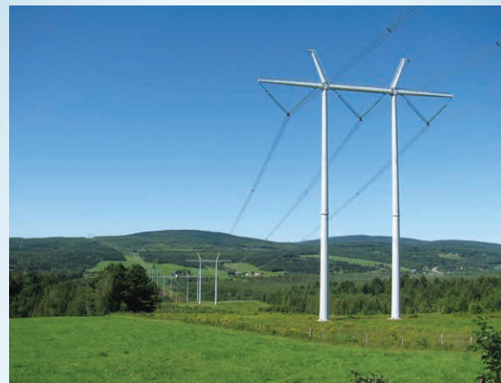
Ligne à 735 kV Cantons-Lévis sur portiques tubulaires dans la vallée près du lac William et sur pylônes à treillis pour le reste de la ligne
