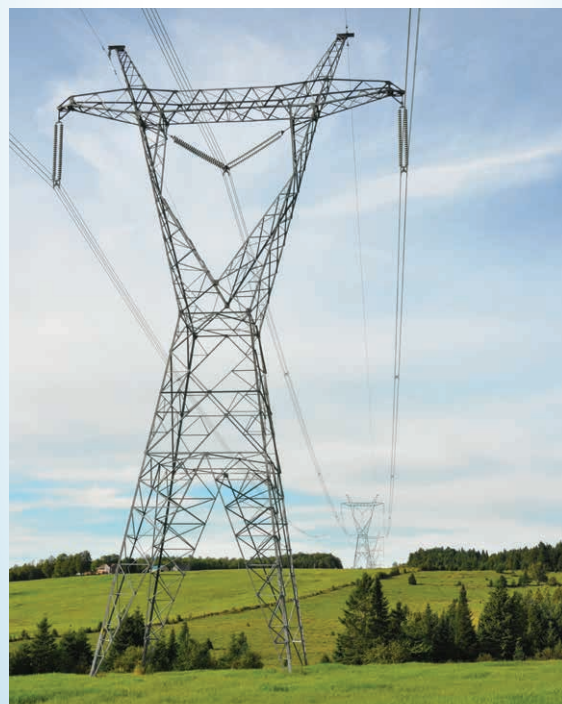
Ligne à 735 kV Cantons-Lévis sur portiques tubulaires dans la vallée près du lac William et sur pylônes à treillis pour le reste de la ligne
