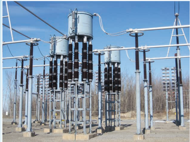
Inductance à noyau d'air au poste de Châteauguay
