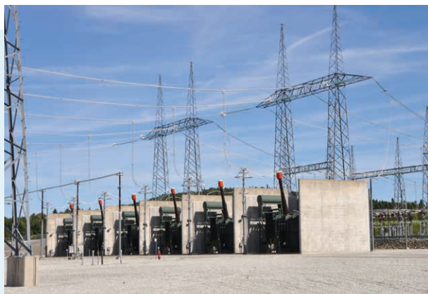
Murs coupe-son des transformateurs de puissance au poste des Appalaches
