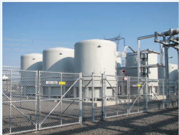
Inductance à noyau d'air avec enceinte acoustique au poste Chénier
