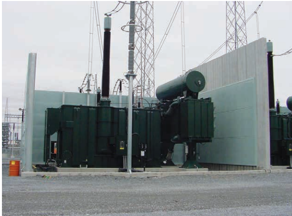
Murs coupe-son en acier avec panneaux absorbants autour d'un transformateur de puissance au poste de la Montérégie
