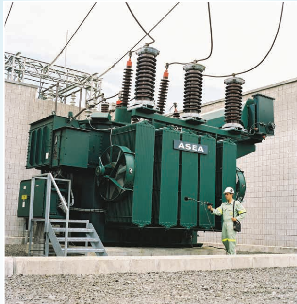
Mesure du bruit d'un transformateur de puissance entouré de murs coupe-son en maçonnerie au poste Doc-Grignon
