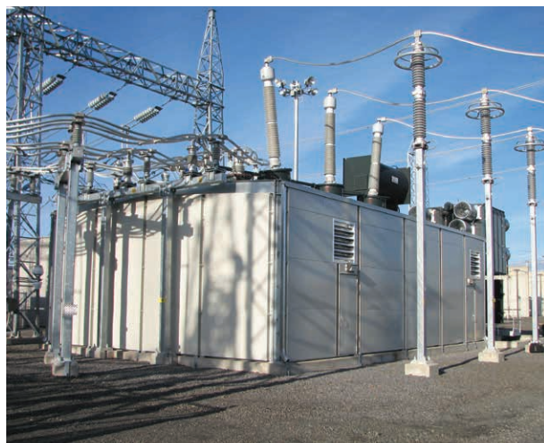
Enceinte acoustique du transformateur de puissance du déglaceur du poste de Lévis
