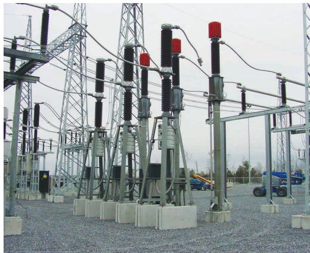
Disjoncteurs au SF 6 au poste de la Montérégie. Les disjoncteurs sont une source de bruit impulsif au moment de leur ouverture et de leur fermeture.
