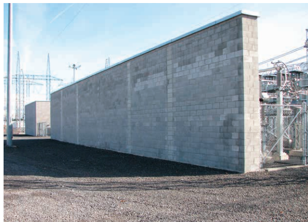
Mur coupe-son situé autour de certains équipements du déglaceur au poste de Lévis
