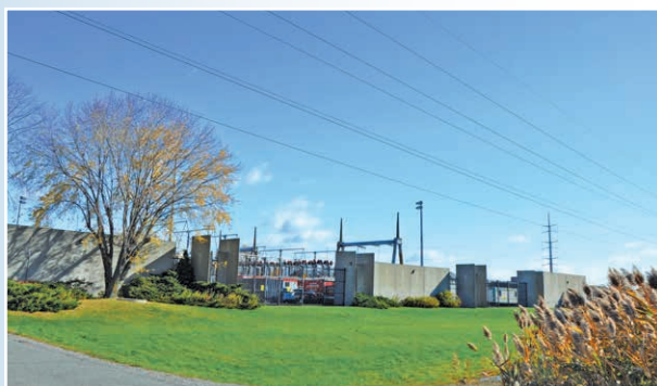
Poste de Brossard (315-120 kV) : poste à technologie surbaissée dont le bâtiment est d'une architecture plutôt ordinaire mais rehaussé esthétiquement grâce à la clôture architecturale qui entoure le poste sur trois côtés. (photo prise en 2012)
