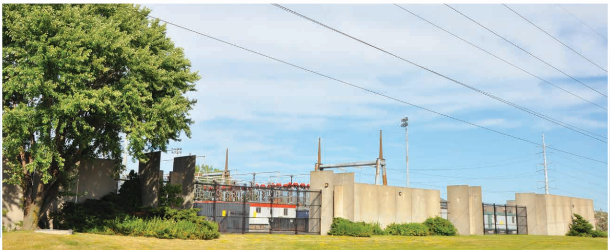
Enceinte architecturale et aménagement paysager réalisés à la fin des années 1970 au poste de Brossard à 315-25 kV (photo prise en 2012)
