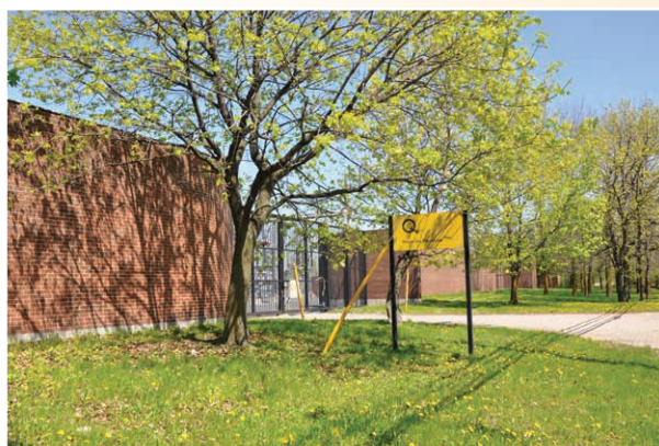
Poste du Tremblay construit en 1979, à Longueuil : poste à technologie surbaissée à 315-25 kV entouré d'une clôture architecturale de briques. Intégration harmonieuse dans le quartier. (photo prise en 2012)
