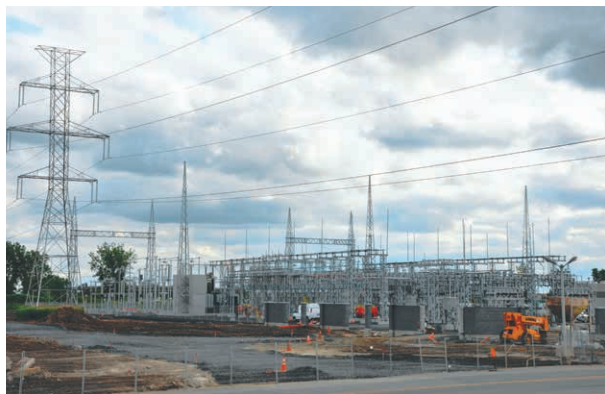
Poste de Saint-Bruno-de-Montarville à 315-25 kV en construction (photo prise en 2013)
