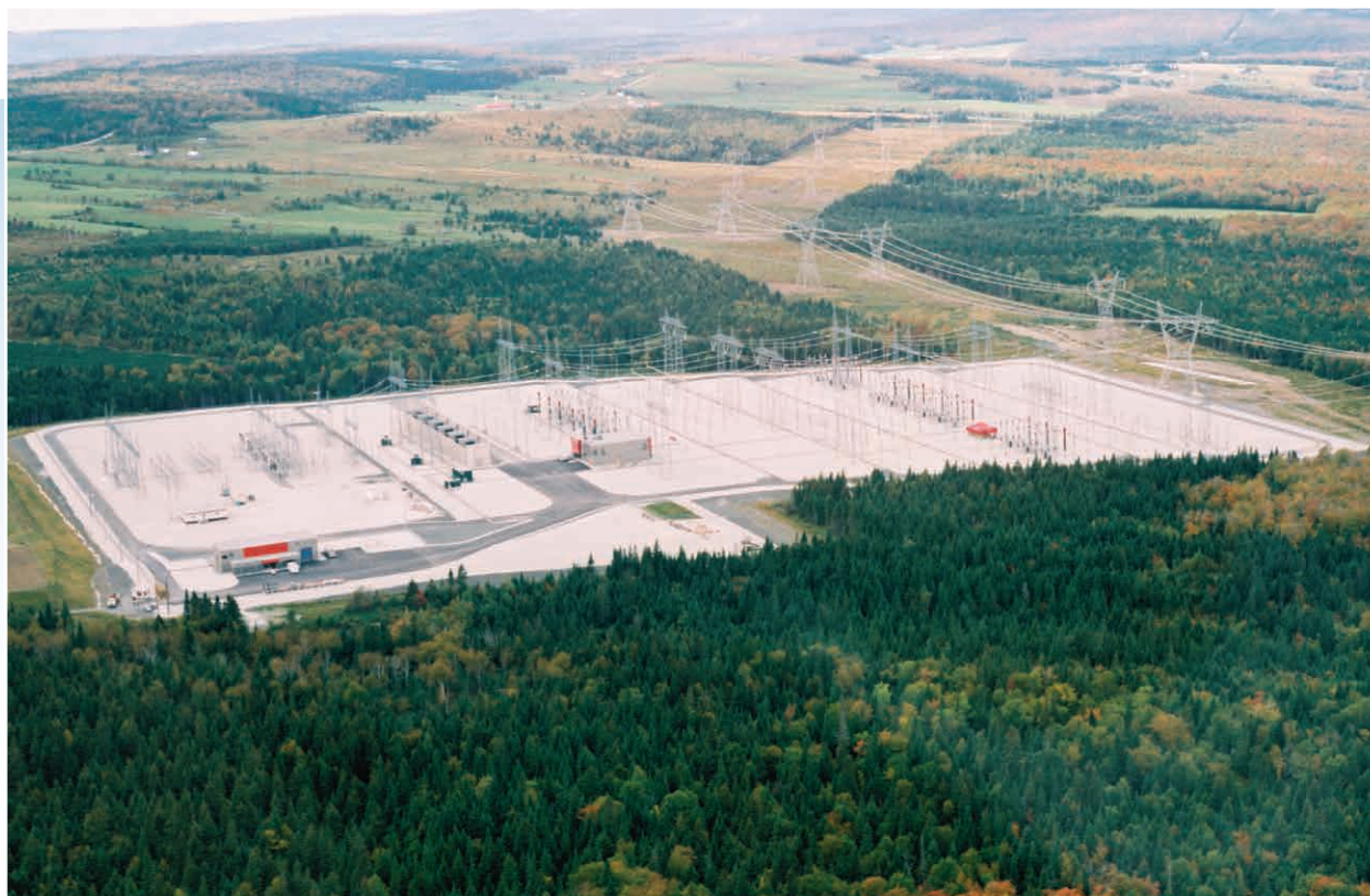
Poste Appalaches (735-230 kV) à Saint-Adrien-d'Irlande La construction en sept gradins permet d'épouser le modelé topographique, et l'échelle du paysage contribue à l'intégration au milieu, mais la couleur blanche brillante du granulat provoque un fort contraste. (photo prise en 1997)
