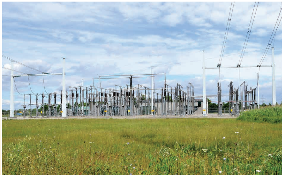
Poste Roussillon (315-25 kV), à Laprairie. Premier projet de poste à 315 kV à avoir fait l'objet d'un rapport du BAPE. Les structures à l'intérieur du poste sont tubulaires et non à treillis. (photo prise en 2012)
