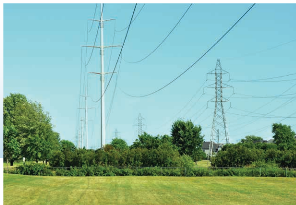
Première ligne à 315 kV sur pylônes tubulaires AVA (7 pylônes) : alimentation du poste Brossard conçue à la fin des années 1970
