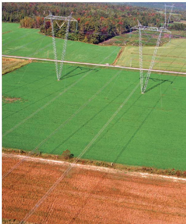
La perte de surface agricole est minime avec le pylône à 735 kV haubané en V, mais ce rendu exige beaucoup d'efforts et de patience – Lignes à 735 kV Canton Mousseau-Chénier (partie méridionale de la Première et Deuxième ligne du RTBJ)
