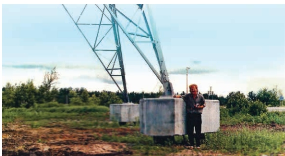
Pylône de la ligne RNDC dont les fondations de béton font 1,5 m de hauteur
