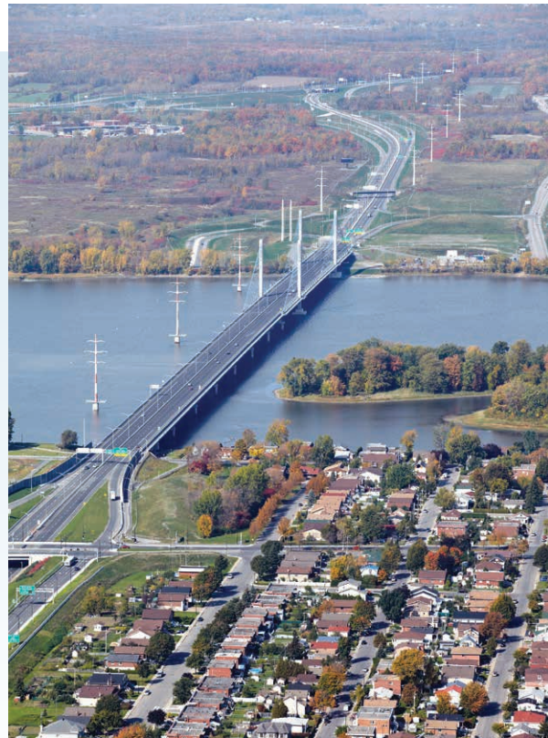
Ligne à 315 kV Duvernay-Anjou sur pylônes tubulaires avant et après la construction du pont de l'autoroute 25
