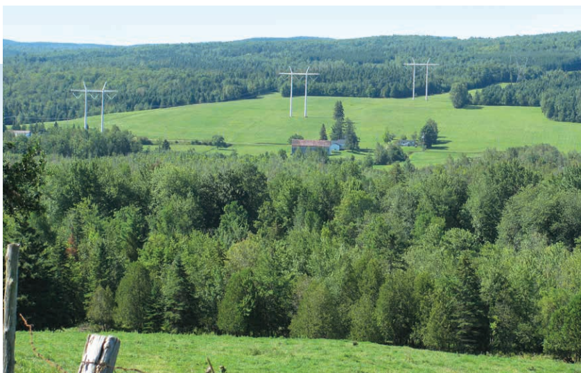
Ligne à 735 kV des Cantons-Lévis sur portiques tubulaires, vallée au sud du lac William
