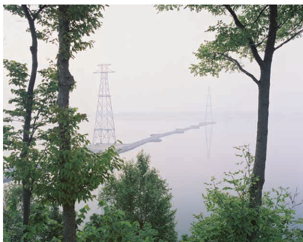
Traversée aérienne temporaire de la ligne à 450 kV c.c. RNDC entre Grondines et Lotbinière
