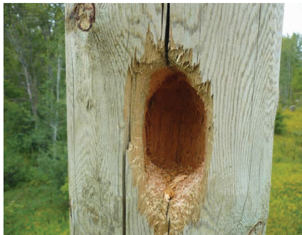
Exemple de trou fait par un grand pic dans un poteau de bois d'Hydro-Québec
