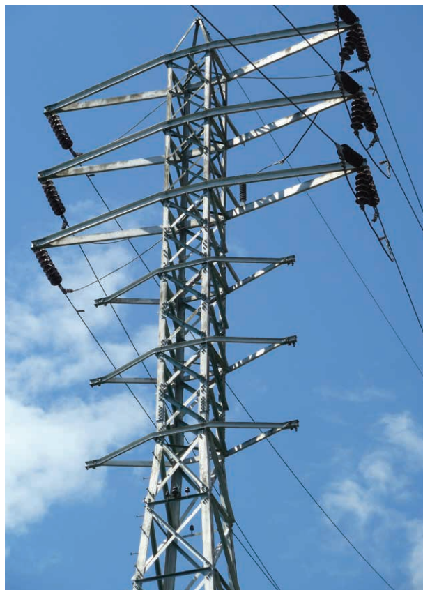
Support à treillis de la ligne Québec-La Reine érigé en 1928 par la Quebec Power Company
