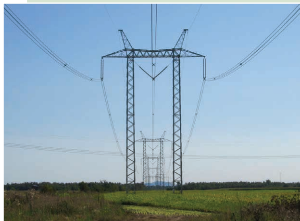
Portique à treillis utilisé entre le poste Hertel et le point Saint-Césaire
