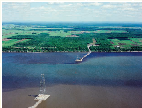
Vue aérienne de la traversée aérienne temporaire de la ligne RNDC lors de la construction en 1988
