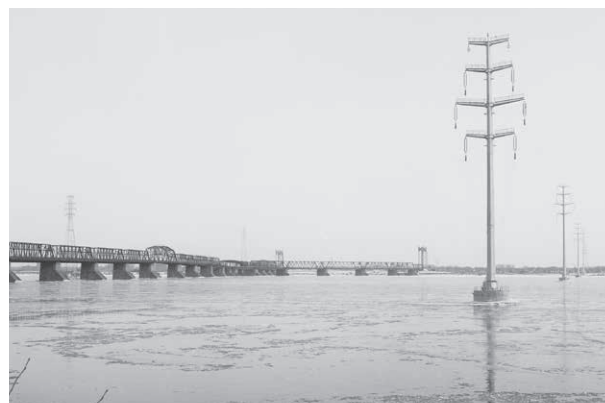
Traversée du fleuve Saint-Laurent sur pylône tubulaire en amont du pont Victoria par la ligne à 315 kV Hertel-Viger au moment de sa construction en 1981
