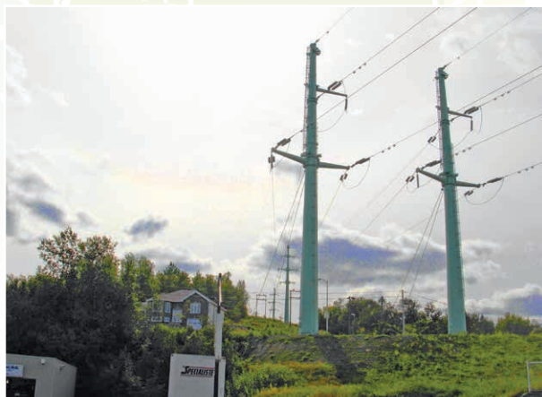
Pylônes tubulaires à deux mâts utilisés pour la traversée de la rivière Saguenay
