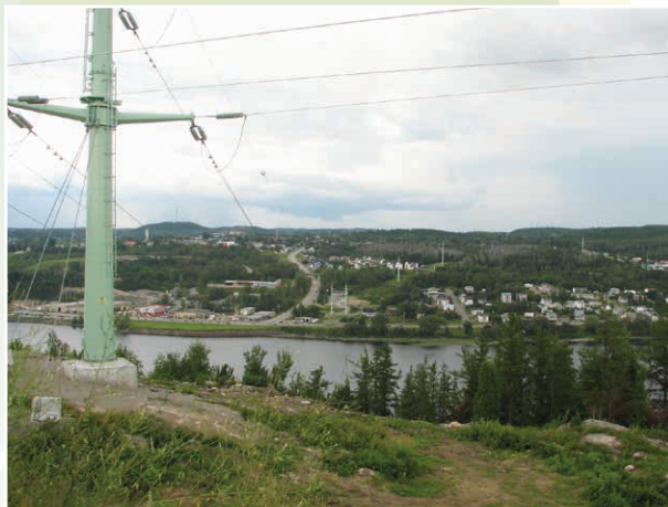
Pylône tubulaire utilisé pour la traversée de la rivière Saguenay
