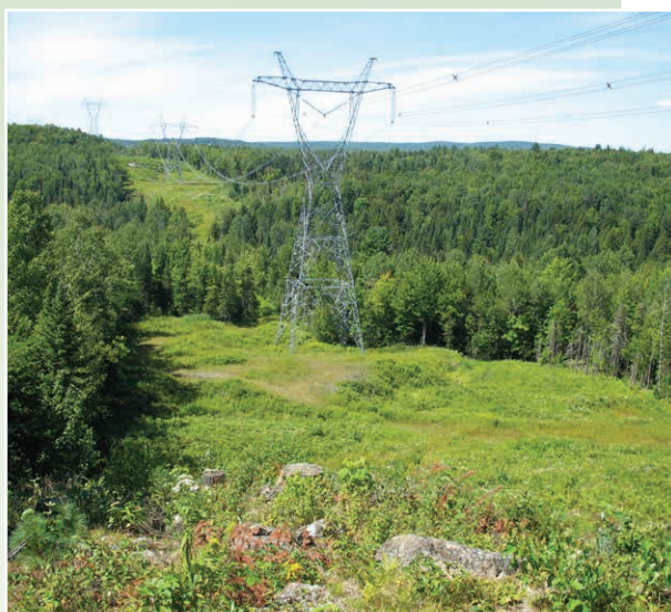
Pylône à treillis traditionnel utilisé entre le point Saint-Césaire et le poste Hertel
