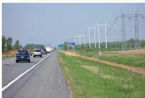
Les pylônes tubulaires à la traversée de la rivière Richelieu déprécient par contraste les portiques à treillis le long de l'autoroute.
