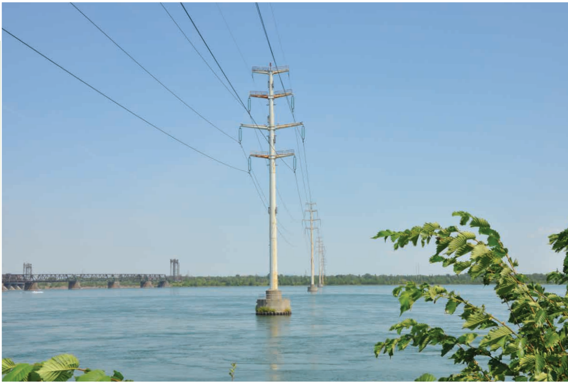
Traversée du fleuve par la ligne à 315 kV Hertel-Viger sur pylônes tubulaires près du pont Victoria, à Montréal
