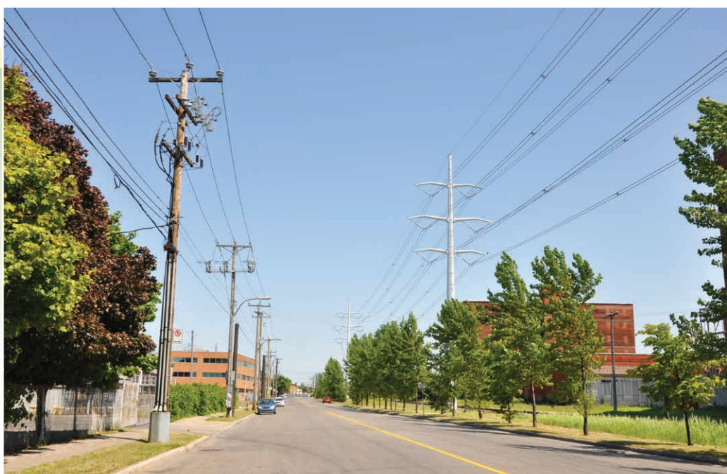
Ligne biterne à 120 kV Aqueduc-Rockfield sur pylônes tubulaires, à droite. Ligne de distribution sur poteaux en bois, à gauche
