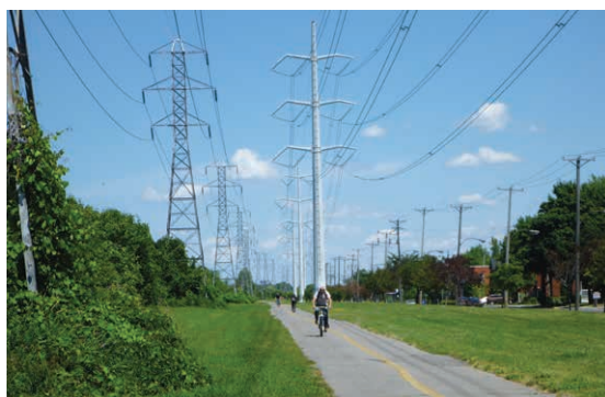
Ligne à 315 kV biterne Aqueduc-Atwater-Viger sur pylônes tubulaires
