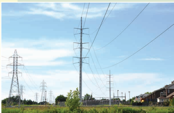
Deux des sept premiers pylônes tubulaires qu'Hydro-Québec a construit à la fin des années 1970 pour la ligne d'alimentation à 315 kV du poste Brossard
