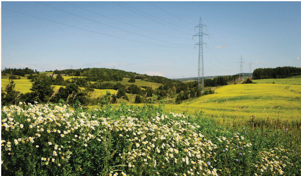
Ligne biterne à 230 kV Rimouski-Les Boules entre Mont-Joli et Sainte-Angèle-de-Mérici
