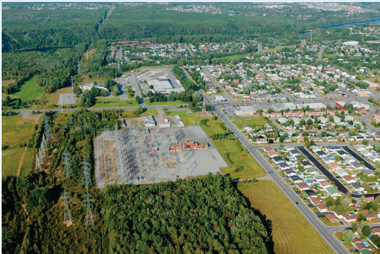
Poste de Trois-Rivières en milieu urbain. Il a été construit par la Shawinigan Water and Power en 1937. Ancien poste à 230-120-69 kV ; aujourd'hui poste de sectionnement à 230 kV. D'importants travaux de réfection ont permis de mettre en valeur son bâtiment de commande à intérêt patrimonial et un aménagement paysager remarquable.
