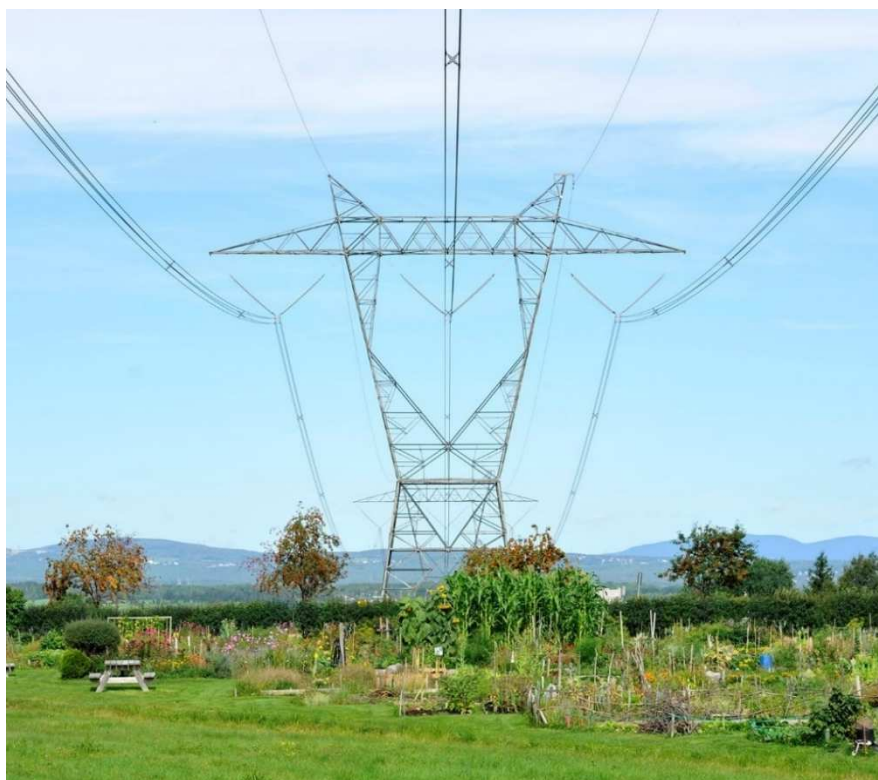
Figure 11 | L'emprise de ligne peut être compatible avec une végétation basse.
